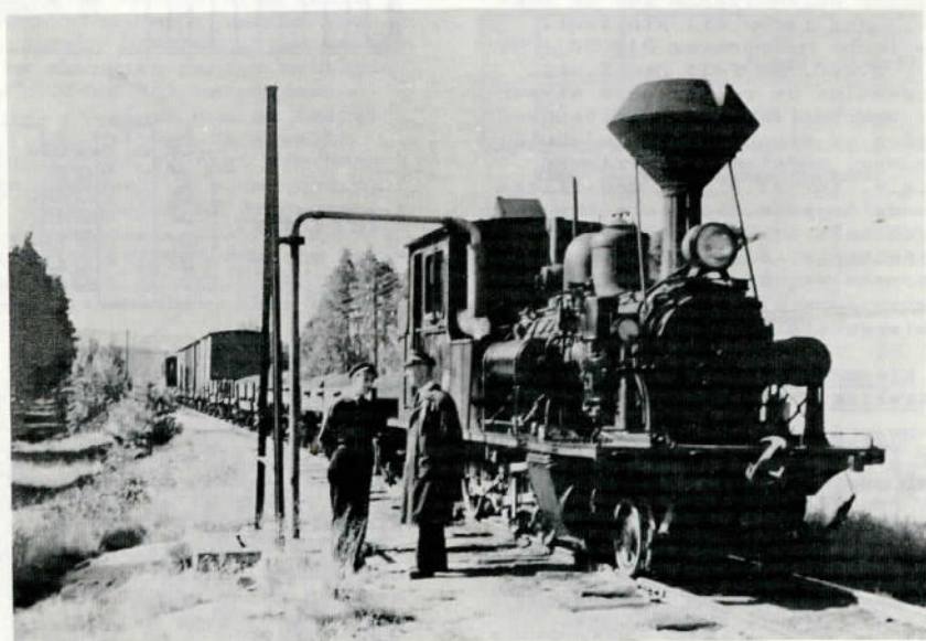
Loko nr.5 tager vand på fri strækning ved Erje station.
