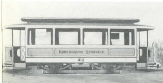
Fig. nr. 4. Første under kommunen anskaffede bivognstype (langsædet).
