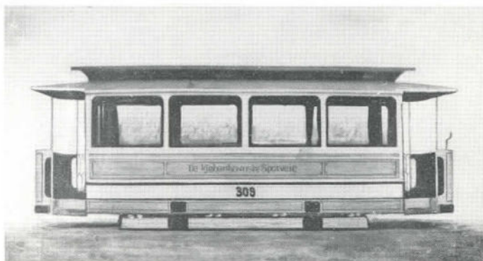
Fig. nr. 2 Første til elektrisk drift bygget bivogns type. (enkelt affjedret).
