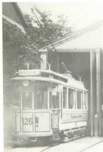
Fig. nr. 2. Hovedtype for toetages motorvogne ved elektrificeringen
