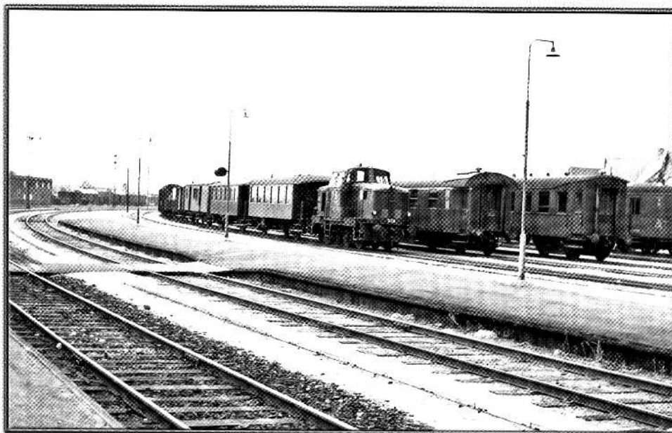
Til venstre: Lav perron med betonforkant. Per- ronen er belagt med asfalt. Læg mærke til lam- perne, og at det bageste spor lig- ger i grusballast. Aalborg 1967.
