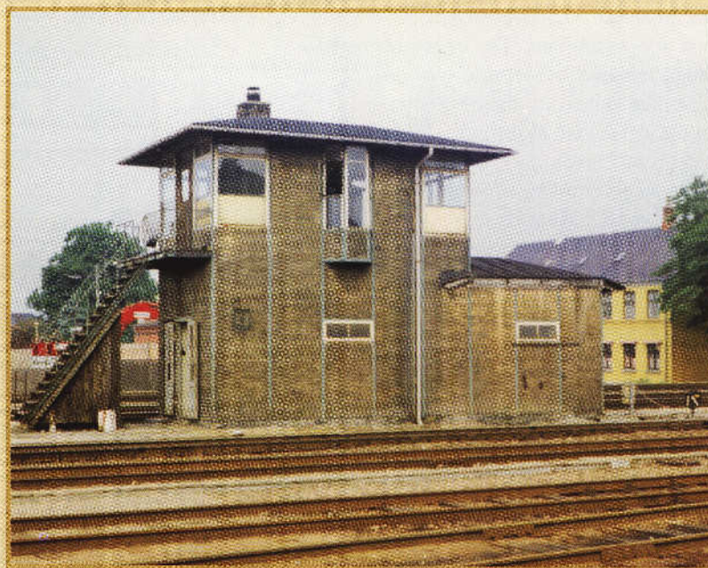
Den nordlige signalpost Næstved, 1979. Posten blev sammen med den sydlige signalpost og kommandoposten på perron III taget i brug 1929. Alle tre blev bygget funktionalistisk i gule sten med mursektionerne adskilt af lodrette stålprofiler. Den nordlige post blev nedrevet i 1983, mens den sydlige faldt nogle år forinden. Rundt omkring på mange af landets stationer kunne man finde samme type signalpost bygget i røde eller gule sten. Foto TA.
