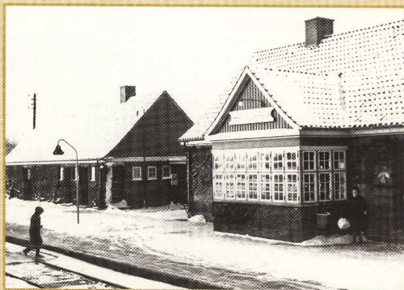
Udbygget signalkarnap på Hedensted station nord for Vejle, 1968. Denne type signalkarnap brugtes i flere versioner på mange landstationer. Læg mærke til signalet på perronen, i daglig tale kaldet juletræet. Dette signal - tre hvide lys i trekant - betød 'stationen ubetjent', og fortalte dermed at tog- og lokomotivpersonalet ikke skulle afvente stationsbestyrerens afgangssignal med signalstokken ('spejlægget'), men blot skulle afgå, når tiden var inde. Foto: JGC/JMJK.
