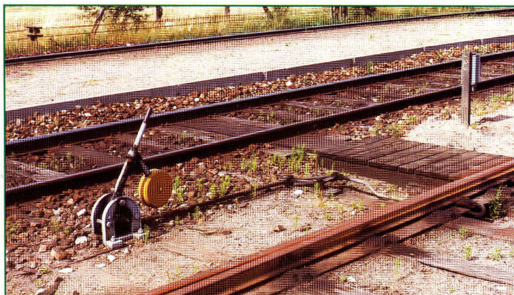
Håndbetjent skifte på Holme-Olstrup station, 1978. Kontrablokken var gulmalet. Til højre ses en del af en kabelrende dækket med brædder. I disse render blev signal- og sporskiftetekablene ledt til/fra signalhuset.
