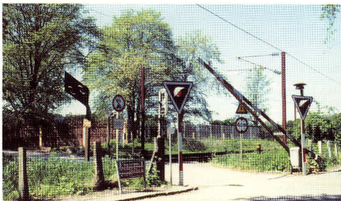
Overkørsel med helbomme, men uden krydsmærker. Vejen er så smal at én bom på hver side af sporet er nok. Ovk. 33 Trepilelæge 1989. Foto: Henrik W Karlsson.
