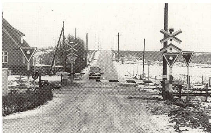
Flersporet overkørsel med halvbomme, krydsmærker og ekstra signal for sidevej. Bemærk at mastereflekterne dengang sad omvendt (hvid øverst). Ovk. 68 Veksø 1957. Foto: James Steffensen, arkiv DMJK.
