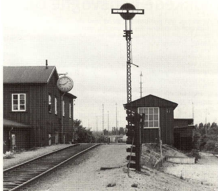
Herunder: Rangerrygssignal af armsignalttype på Århus rangerbanegård, 1974. Begge signaler er vist på signalplanchen i nr. 62. Fotos: S. Levinsen.
