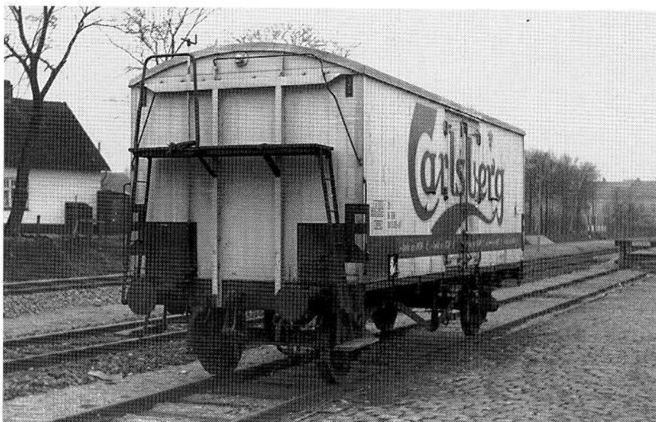
På grund af ølvognenes flade tag var det ikke muligt at få plads til rangerskruebremsen i selve gavklædningen, så den måtte rage op over taget. Bemærk de sorte felter i gavlen, der var malet for at tydeliggøre underretningstavler. Vognen er 20 86 081 5 015-6, bygget Scandia 1953, og den er fotograferet i 1970 (ukendt fotosted). Foto: Guldbæk.
