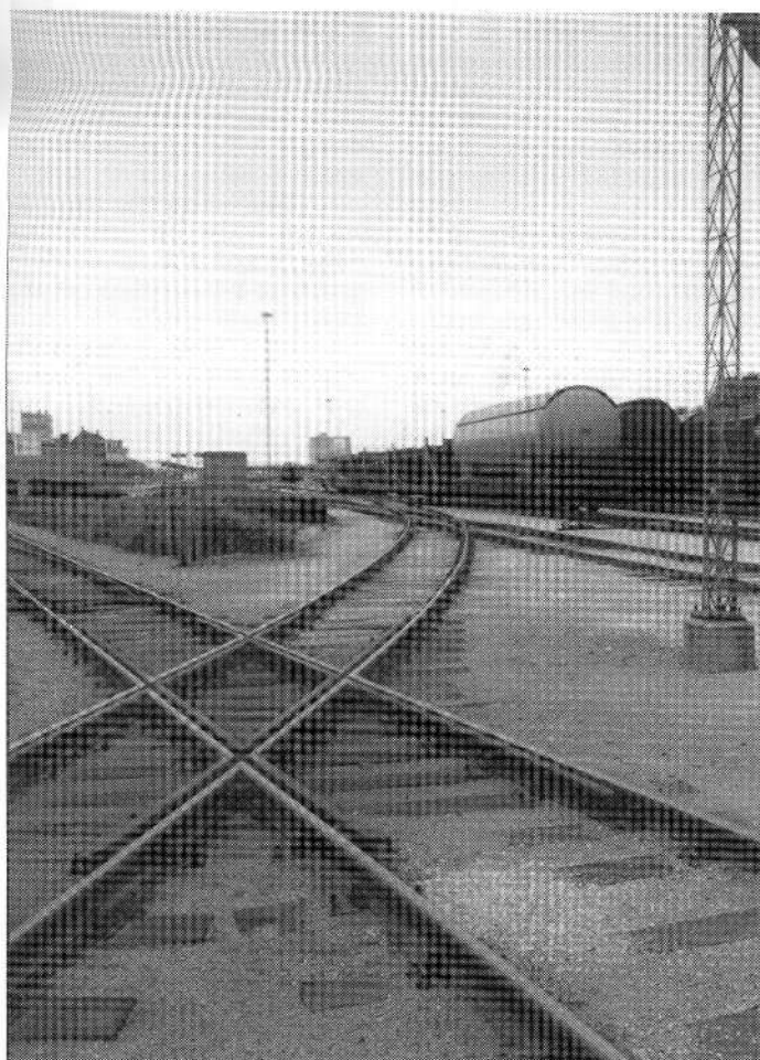
Sporkryds er almindelige på mange danske stationer. Her et eksempel fra Kalundborg, 1991, hvor havnespor krydser industrispor.
