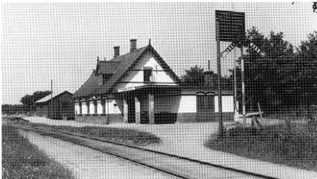
Nyråd station, Kalvehavebanen (KB), juni 1959: Kalvehavebanen havde ingen krydsningsspor - kun læssespor, men alligevel dobbeltarmede signaler. De blev således anvendt både på krydsningsstationer og »almindelig« station. Kun stationsstyrerens samvittighed synes at forhindre, at begge arme blev hævet samtidig!
