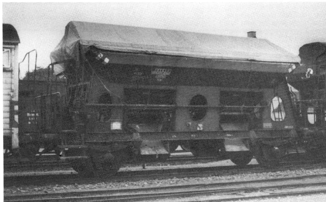
I begyndelsen af 70'erne manglende DSB Tdgs-vogne til transport af kunstgødning, og man indrettede i stedet nogle ballastvogne litra Fd til denne transport. For montering af presenning anbragtes et rørstativ oven på Fd-vogne. Desuden svejsedes rør på alle kanter - også hele overkanten - af vognen. Endnu i dag kan disse vogne genkendes på de påsvejsede rør, der endnu ikke er fjernet 24 år efter. Her 602 0 605 med kunstgødning i Saksøbing 1971. Foto: Per Topp Nielsen.
