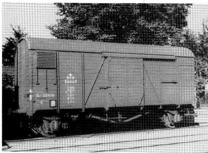
HD 38 647 på Frederiksberg, 1966. Den har brun vognkasse med hvide påskrifter. Akselkasserne er de store af Isothermostyppen. I modsatte gavl sidder bremseplatformen. Lige under påskrifterne anes bremseomstillere. Foto: K.E. Jørgensen, Hvidovre
