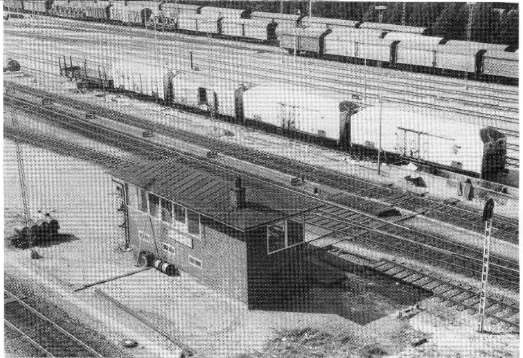
Post 2 med gamle træ- og nye betonkabelrender set fra sandtårnet ca. 1974.
