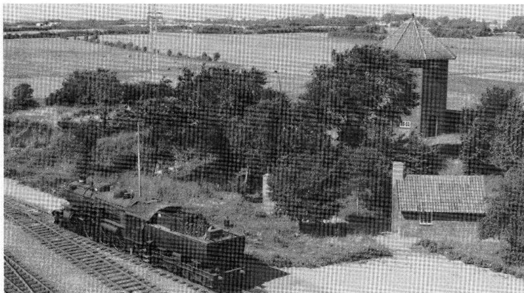
Vandtårn m.v. øst for remisen, 1971.
