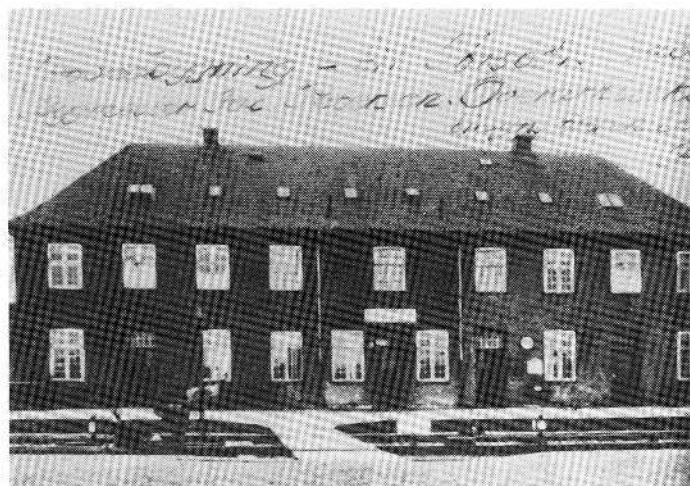
Hovedbygningen med perron for togene til Tørsbøl omkring 1930. Arkiv: N.E.Jensen.
