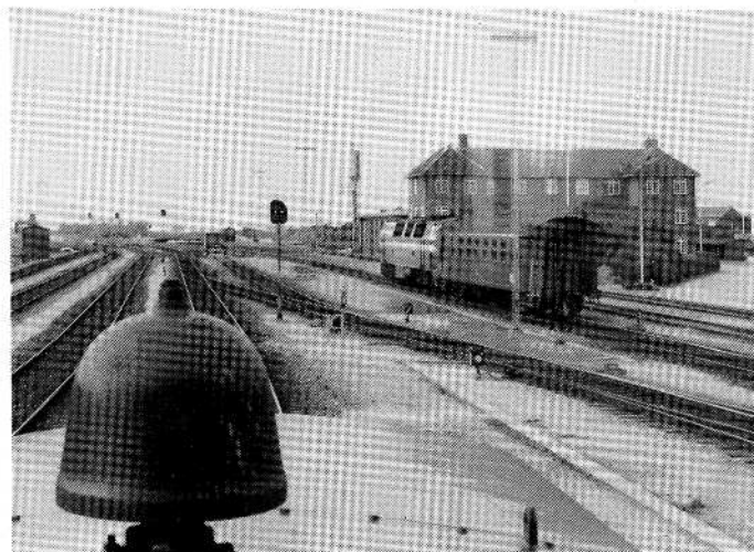
Remisens »administrationsbygning« set fra syd i 1977. PU-signalerne har aflåst TU-signalerne og sporrettet er forenklet.
