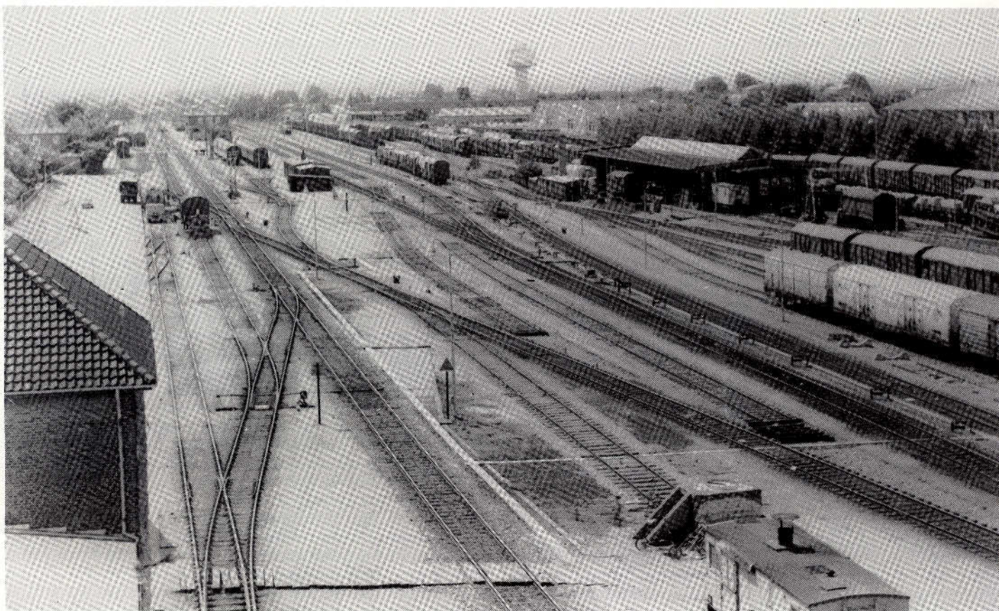
Stationsarealet set fra maskindepotet mod syd. Bagest til venstre i billedet ses ekspeditionsbygningen og tre vogndepotspor med vogne. Foran disse ligger togopsyns- og relæbygning og koksskur. I baggrunden lidt
