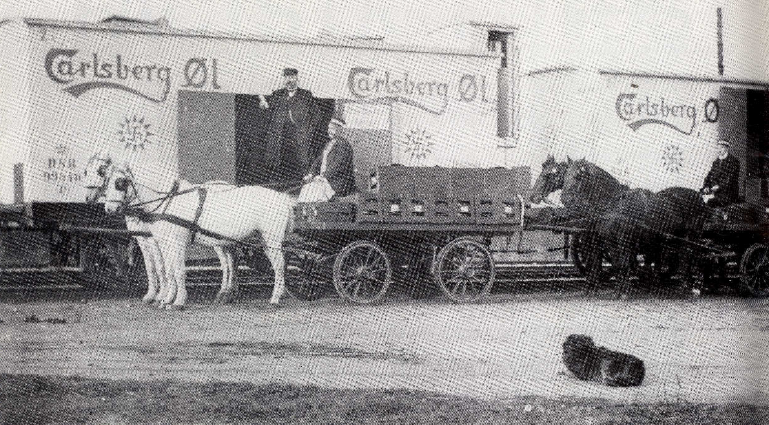
Stemningsbillede fra Vedbæk station omkring 1908. To Carlsberg ølvogne på læssevejen overleverer øl til hestetrukne ølvogne, mens hunden daser på jorden. Forrest ZA 99 548 med bremsetårn, bygget Scandia 1901. Vognen ved siden af er muligvis ZA 99 516, bygget Scandia 1890 (høje døre og delvist læsbart nummer). Begge vogne er udsmykket
