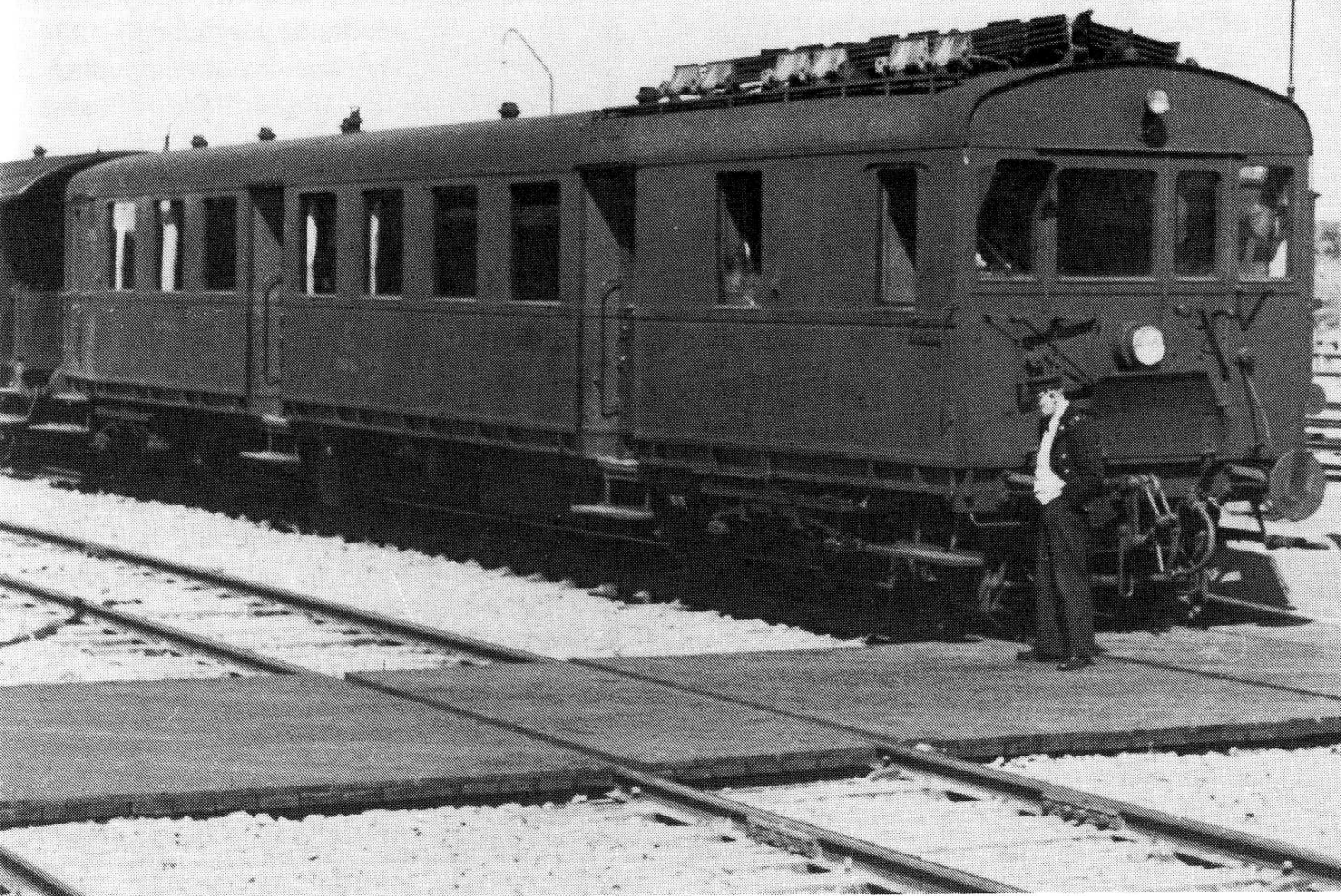
Et af de få fotos, der viser MQ i drift: Ukendt MQ på Ny Fredericia Banegård, maj 1935. Motorvognen har en 2-akslet CFM (CXM) og E-vogn på slæb.
