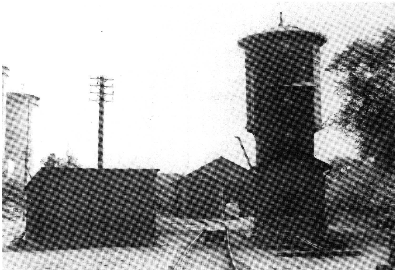
Her ses vandtårnet i Assens fra den modsatte side som på billedet fra 1959. D-maskinen og kulkranen er forsvundet, men ellers er miljøet intakt. I baggrunden ses remise og oliebeholder for rangertraktoren i Assens. Redskabsskuret står - pudsigt nok - lidt skævt for sporet. I øvrigt bør man lægge mærke til skinnerne på sveller i forgrunden, samt askegrav af mursten. Udseendet af vandtårnet skulle her fremgå tydeligt. Motivet er fra 1966.
