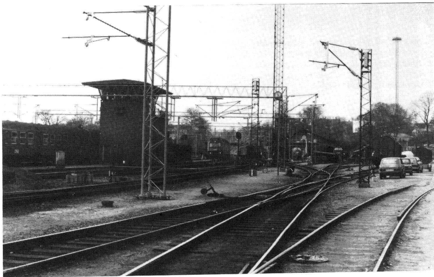
Gitterportal med K-oophæng under montage på Helsingør Station i april 1984.
