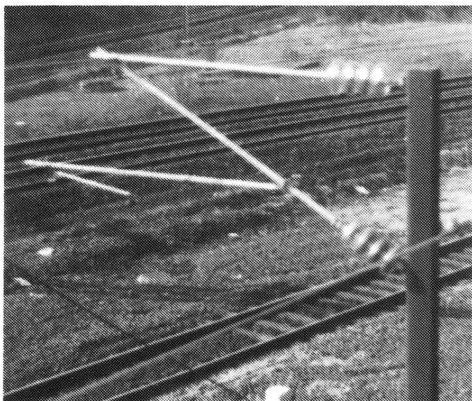
Standard K-ophæng på strækningsmast af corten-stål. Bemærk, at returledningen sidder bag på masten, da denne er placeret i en relativ skarp kurve. Svanemøllen, marts 1986. Foto: SD
