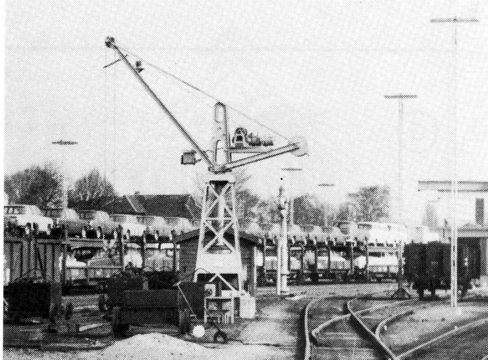
Typisk DSB-kulcran med tilbehør: små kulvogne, skovle og "kolonnehus" for mandskabet lige bag kranen. Lidt i baggrunden anes en vandkran. Nyborg 1970.
