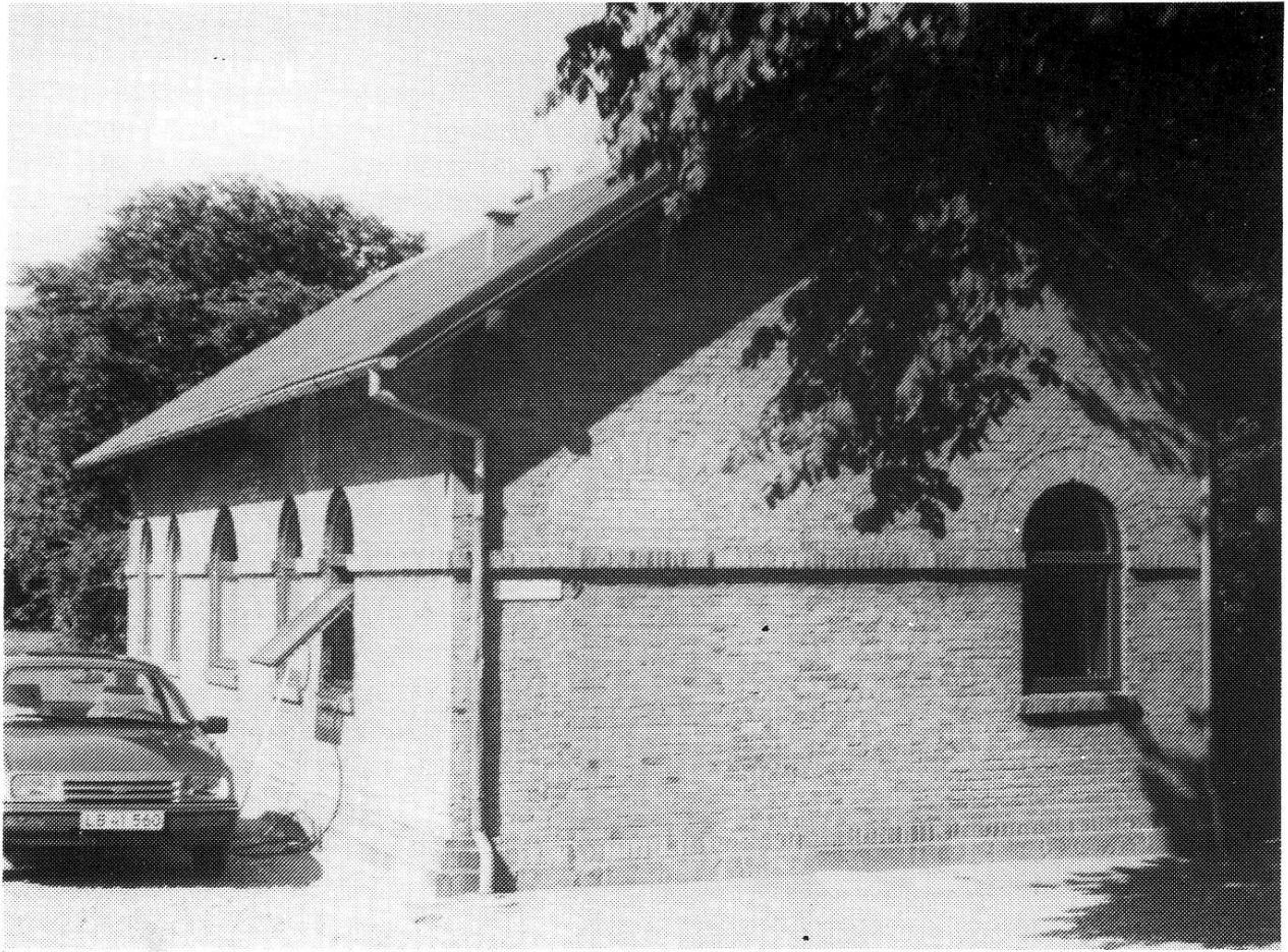
Fig. 5. Varde Kolonnehus set fra øst den 16. juni 1986.
