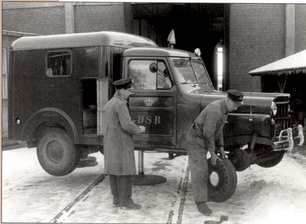
DSBs udrykningskøretøj i Odense, 1958. Man er ved at skifte vejhjulssæt over til jernbanehjul. Foto: DSB.
