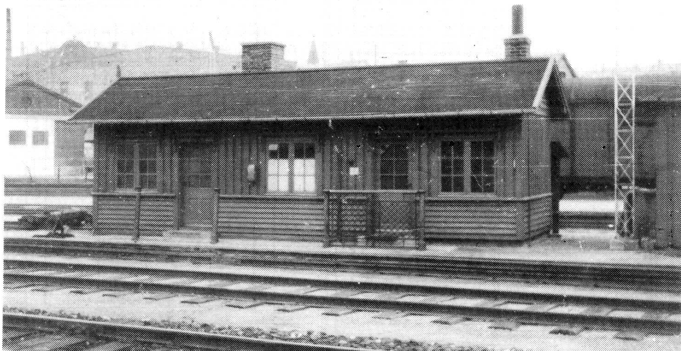
Fig. 4. Når et kolonnehus skal være af træ, kan det være udført på flere forskellige måder; her har vi et eksempel på sjællandsk byggeskik repræsenteret ved kolonnehuset på Frederiksberg st. set fra sydøst den 2/11 1967. Bemærk klinkbeklædningen fornedet, vinduer med tynde sprodsler, beskyttelsesgelænder foran dør og to forskellige skorstenspiber.
