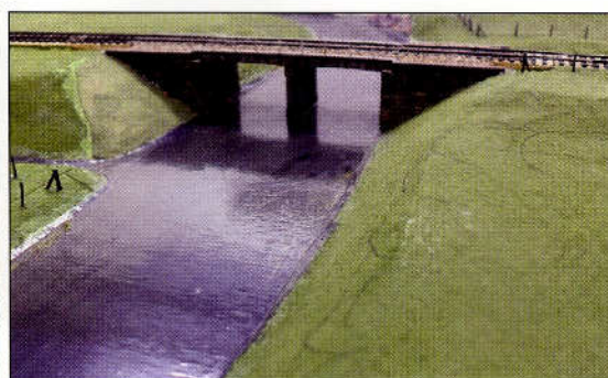
Den oprindelige bro over Tved Å var også en gitterkonstruktion i et fag. Brohovederne viste sig dog ikke at være tilstrækkeligt funderede i forhold til strømmen i åen. Den stod i 49 år, før den i 1924 brød sammen. Man måtte derfor etablere en midlertidig konstruktion af træ, inden den nuværende bro med størpille i midten kunne tages i brug i 1925. Billedet viser modellen set fra vest.
