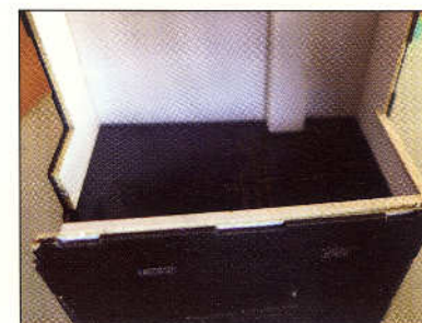
Fig. 15: Vindueskarm og indervæg E-9 er monteret.
