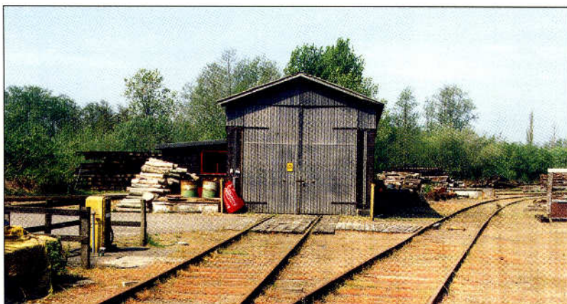
Traktorremise på Randers station, 1988. Til venstre ses benzinstander til påfyldning af brændstof på rangertraktoren.
