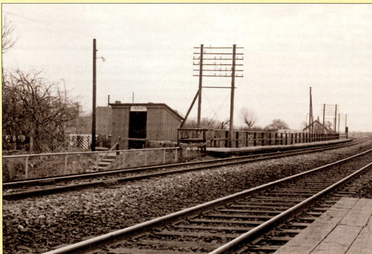
Ring trinbræt mellem Næstved og Vordingborg, 1968. Her ligger perronens brædder langs med sporene. Bemærk de dobbelte master med telefontråde. Foto: KEJ
