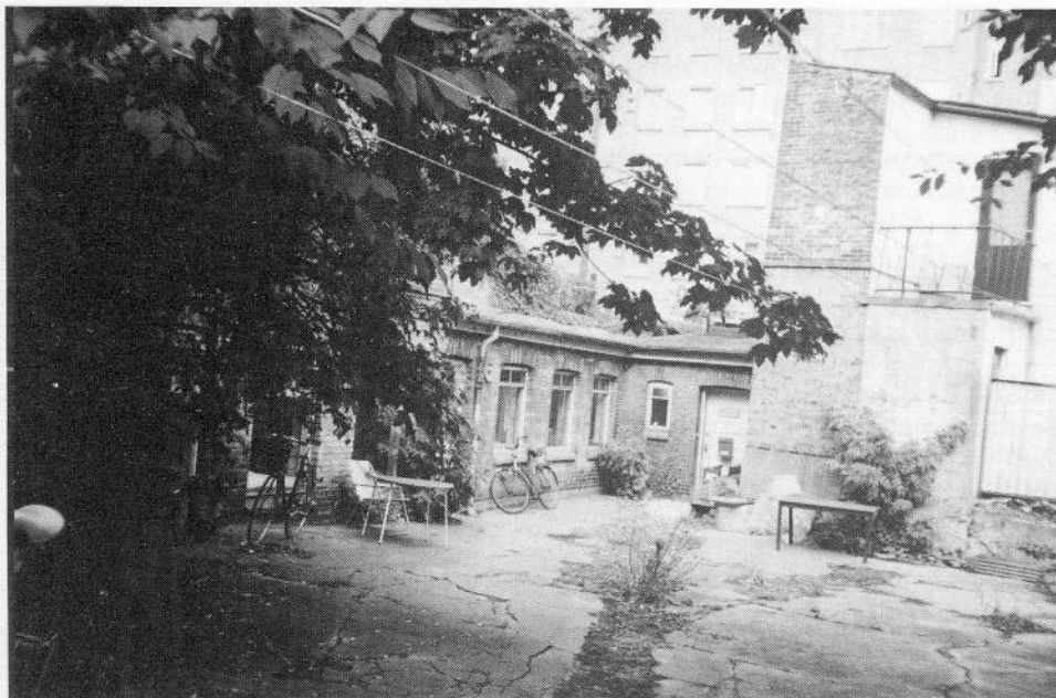
Fig. 8. Kontorbygningen og toilet-facaden i tilbygningen; til højre gavlen af det ombyggede bageri.
