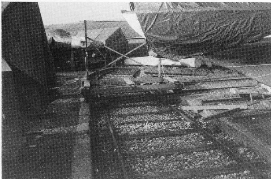
Fig. 6. Skydebro med dobbeltflangede hjul kørende på såvel krumt som lige spor. Stige lystbådehavn, Odense, set fra øst. 9/2 1992
