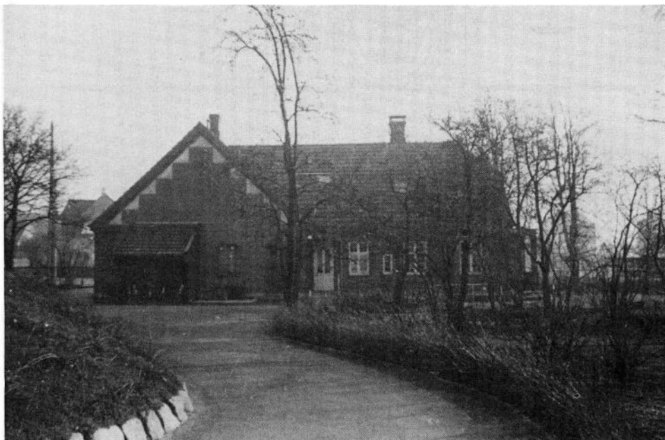
Fig. 5b. Søborg vandværks bagside, set fra vejen til værkstedsbbygningen.
