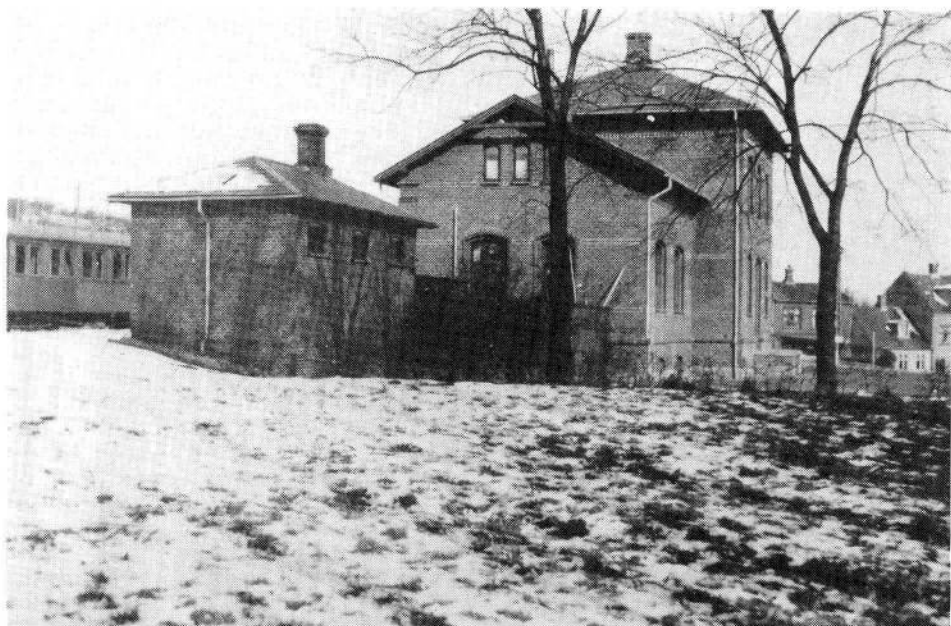
Kolding Nordbanegård, set fra vejsiden omkring 1920. Affoto fra Jernbanemuseet.
