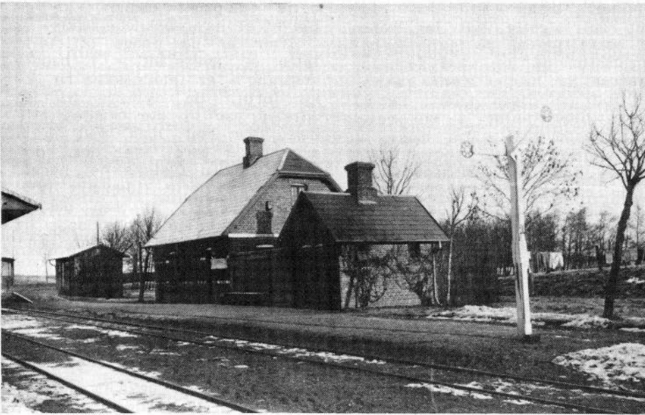
Haurballe station. Bemærk plakatrammen på plankeværket. Det lille varehus er muret op. Det har udvendig skydedør og 2 vinduer mod rampen. Ved spor II ses et taghjørne af et privat varehus. I spor I et hjørne af en person- eller post/bagagevogn. (Arkiv: B. Wilcke)
