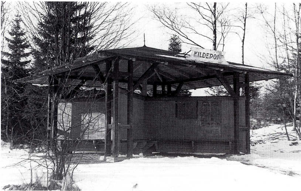
Kildeport trinbræt på en vinterdag, 1969. Kildeport trinbrætbygning er af samme type som Gribso (og Duemose), d.v.s. en åben korsformet bygning. Ved det lidt større Kildeport trinbræt er "korsarmene" dog hver forsynet med ekstra stolper og større skråafstivninger.
