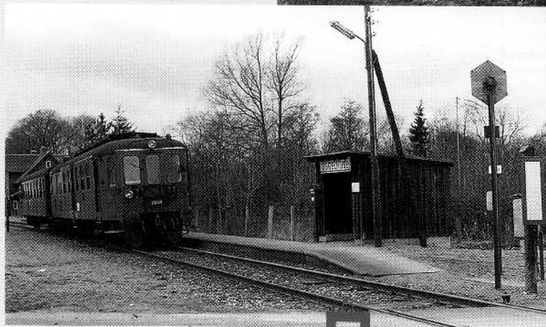
Herover: Dette trinbræt - Holsteinborg - lå på Næstved-Slagelse banen, og var et typisk DSB-holdsted med læskur i rød, gelænder i træ langs bagkanten, sikringsanlæg, lysmast m.v. Perronerne har en lille betonkant, og er anlagt med jord, grus og græs. Læg mærke til telegrafpælen i venstre side, de(n) må heller ikke mangle på anlægget. Foto fra 1968, KEJ.
