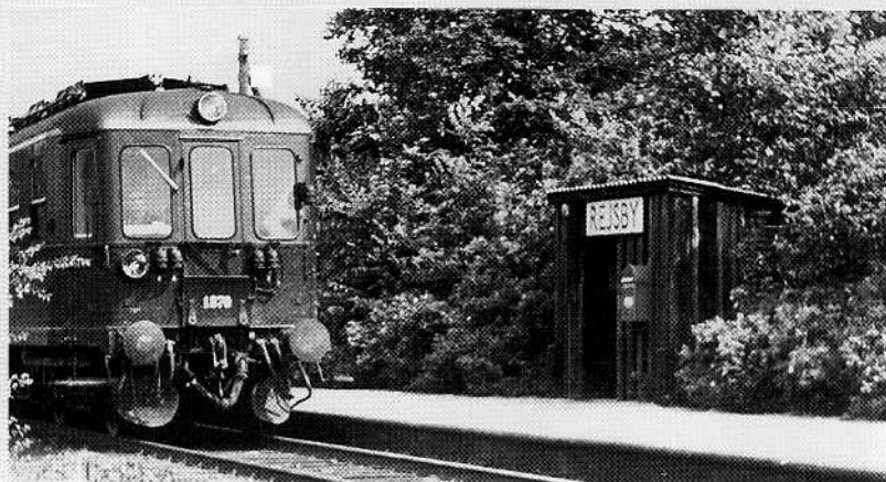
Til venstre: Her er vi i Jylland, nærmere betegnet Uggehusse mellem Ryomgård og Randers, hvor MO 1982 gør holdt ved trinbrættet. Også her har man læskur træ, der er rødmalet, lysmast m.v. Perronen har betonkant, og er lagt med betonfliser. Langs bagkanten står et almindeligt hegn med træpæle. Bemærk standsignalet (af langt hvidt mærke med rød kant), der betyder "perron ved trinbræt". Bag dette anes et telefonskab. Foto fra marts 1971. Gunner W. Christensen
