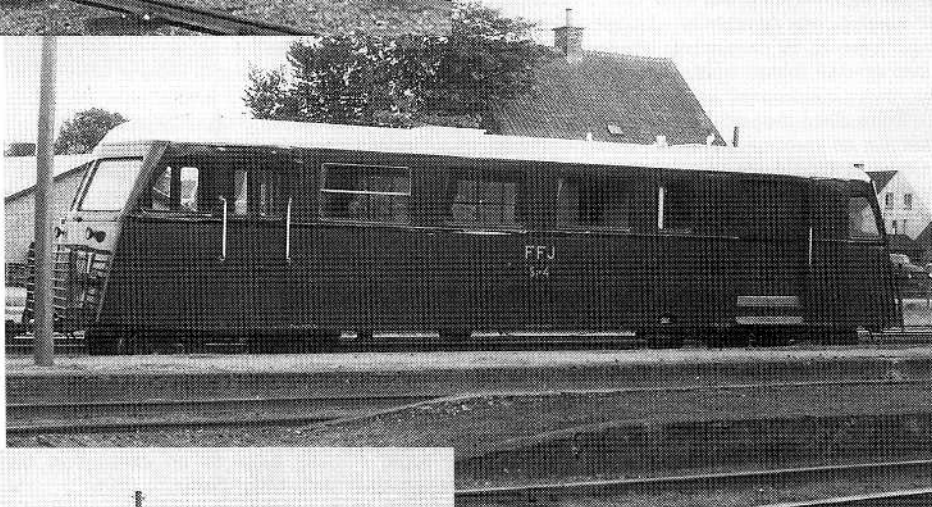
FFJ SP 4 (bygget Scandia 1948 - serie 1) var en typisk skinnibuspåhængsvogn med rum til rejsegods. Bemærk de hvide håndgreb ved dørene og de to små slutlygter. Vognen har oliefyrt i rejsegodsrummet, og påfyldningsstudsene til dette ses nederst i vognsiden. Køretøjet er fotograferet på Hadsund N, 1964. Chr. Oddershede. ▼
