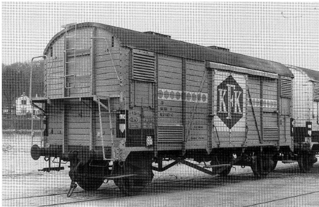
KFK 022 1 021 med platform UDEN skruebremse, Odense Havn, ukendt år. Foto: Per Topp Nielsen, Saksøbing
