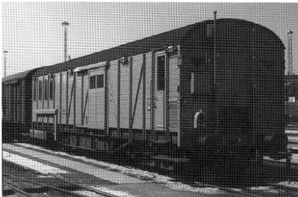
Hjælpevogn nr. 982 0 002-5, København Gb, 1982. Selv om gavlen er lidt mørk, skulle det være muligt at ane døre og overgangsbros samt andre gavdetaljer. Bemærk, at dørene er i pladejern. Foto: HQ/Arkiv PÅ SPO-RET.
