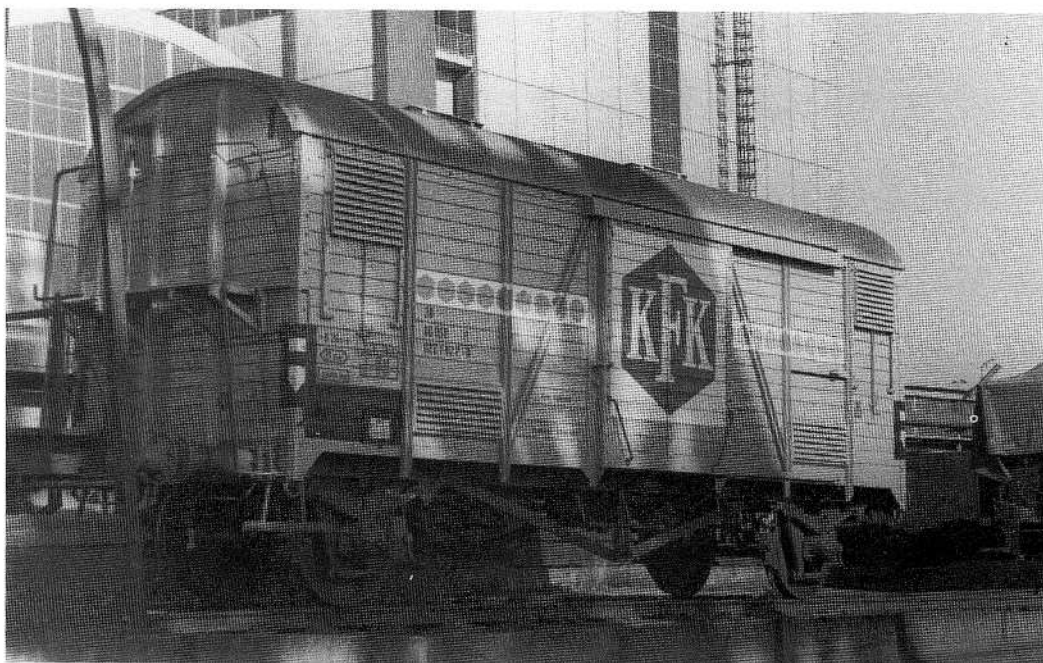
KFK 022 1 022-8 (ex. IAR 21 259) i Århus, 1975. Vognen er set fra gavlen med bremseplatform. Den har to læsselemme, men endnu ikke løbebro på taget (der er ingen stige fra bremseplatformen til taget). Løbebro og stige blev dog monteret året efter. Foto: K.E. Jørgensen, Hvidovre.
