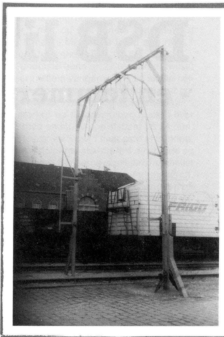
Fig. 12. På Esbjerg station er benyttet en anden konstruktion, hvor topmålene kan skiftes ved snoretræk på højre stolpe. Galgen er forstærket med trekantede, både oppe og nede. Bemærk "hundene". Set fra sydøst den 20. august 1985.
