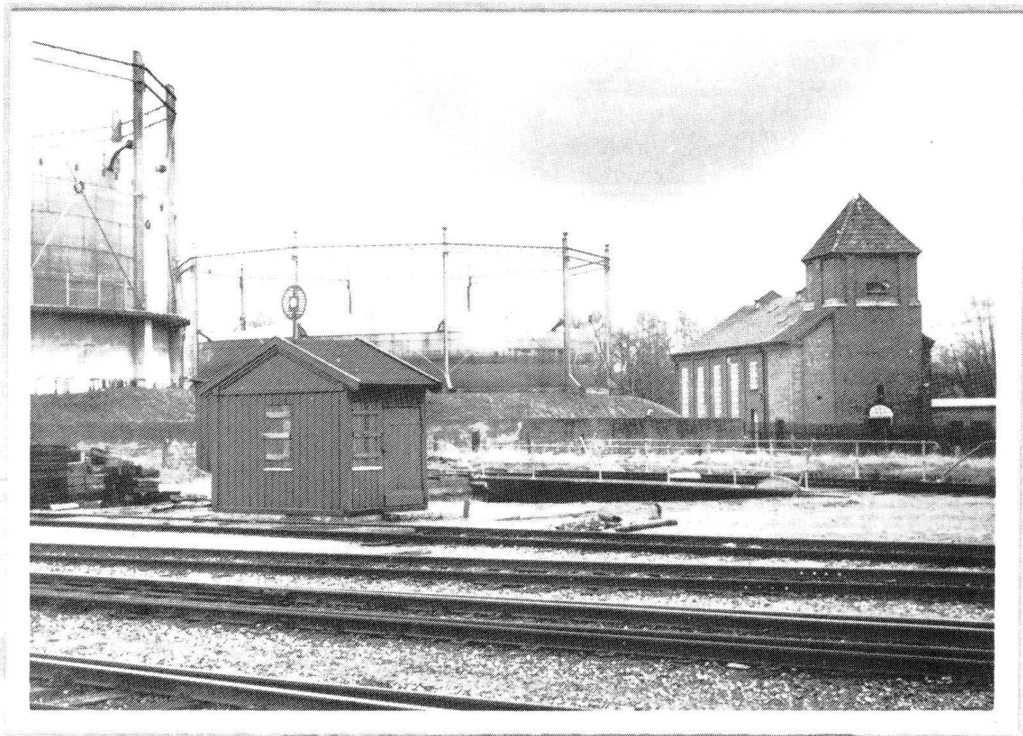
Fig. 10. Vejerboden i Grenå er kun taget med for at vise brugen af et gammelt skivesignal, som et kendes fra de gamle sporskifter. Stedlige vandaler har formentlig nødvendiggjort tilspigring af lemme for vinduerne. Set den 2. december 1971 fra nordøst.
