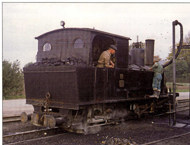
FJ IV tager vand ved remisen i Stubberup, 1966. Foruden remiseanlæg i selve Stubberup, var der indrettet et lidt mere simpelt forsyningsanlæg i Faxe Ladeplads. På taget ses billygten tydeligt. Pufferne sad meget lavt på alle lokomotiver, naturligvis af hensyn til de små åbne kalkvogne. Foto: Egon Nielsen/ Arkiv V.F. Hejlesen.
