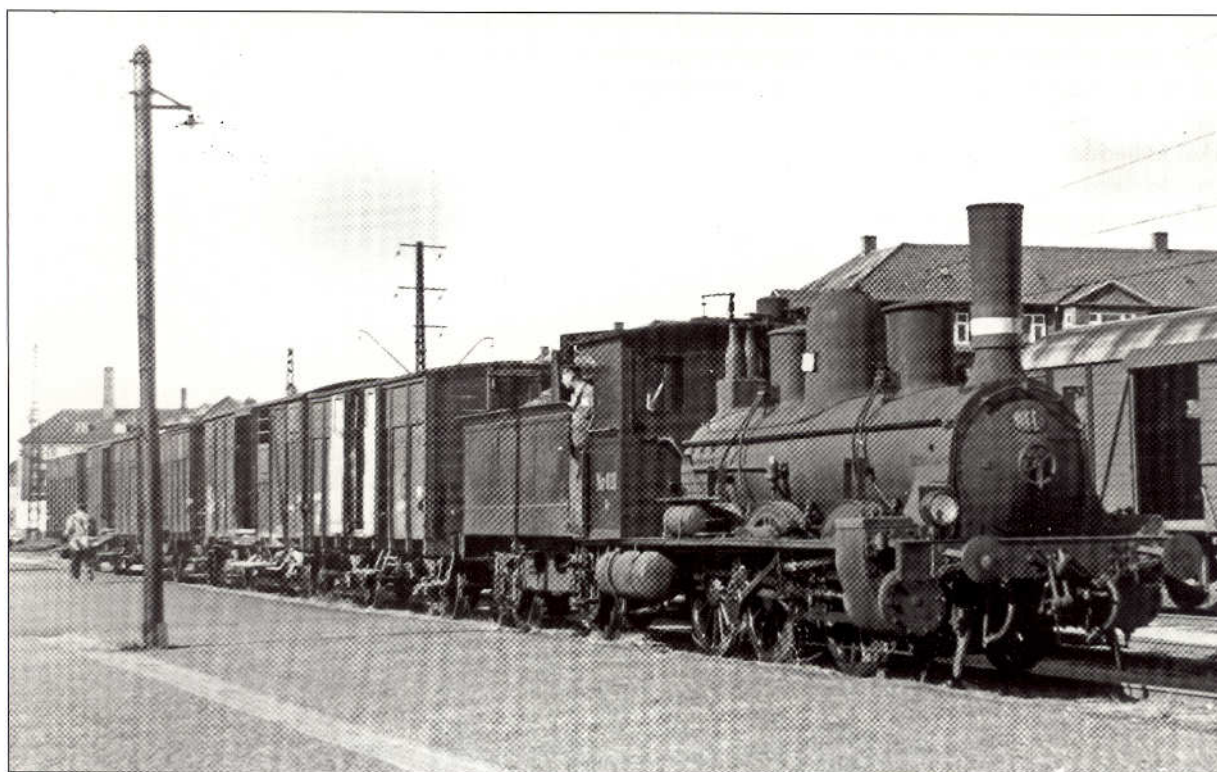
G 602 rangerer med godstog i Hellerup, 1956. Den hvide plade på domnen - en advarsel mod elektriske ledninger - havde alle damplokomotiver, der var stationeret i 1. Distrikt (Sjælland). Foto: AD/DMJK
